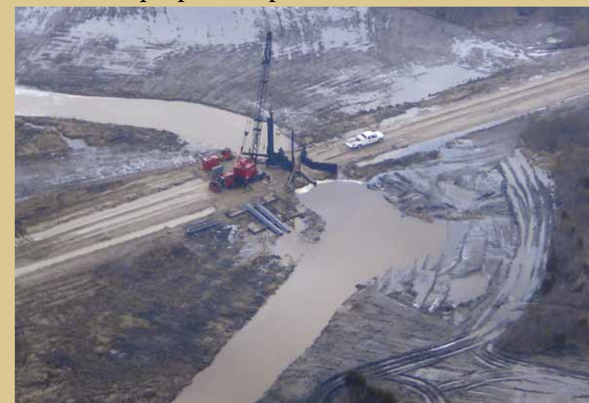
Un des dispositifs de régulation de l'eau, ou déversoirs, en cours d'installation.
