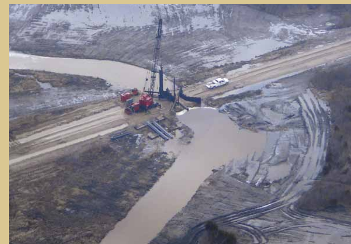
正在安装的一个 South Cape May 堰
